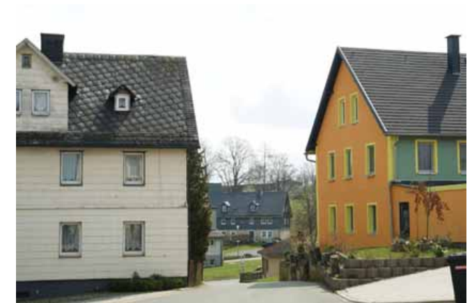
Siemesweg, unterer Abschnitt von Nordwesten
