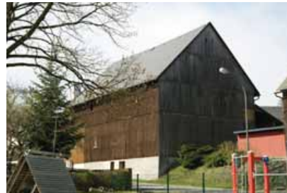
(II.) Scheune von Südosten
