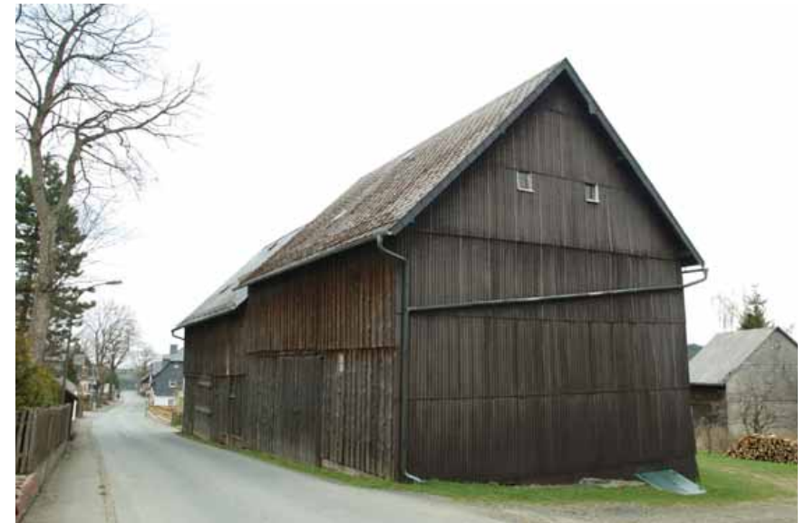
(I.) Scheune von Südwesten
