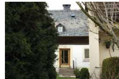
(I.) Hauseingang von Südosten
