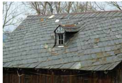
(II.) Schuppen, Schieferdach
