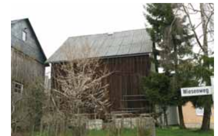
(II.) Scheune von Südosten
