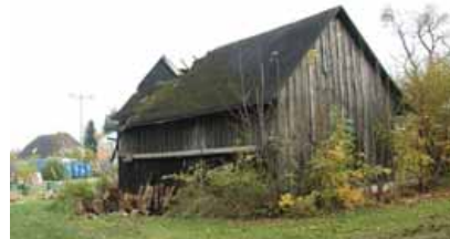
(III.) Schuppen, Fl.Nr. 33, von Nordwest CR2136
