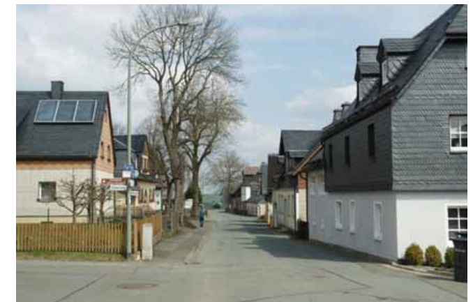
Schleeknockstraße, nördl. Abschnitt, ortsauswärts von Südwesten CR1117
