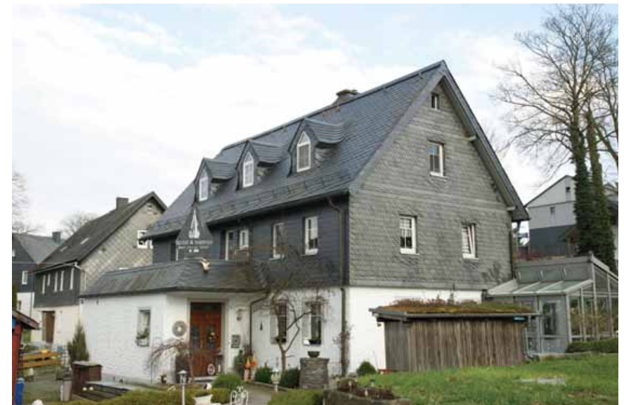
(I.) Wohnhaus von Nordwesten
