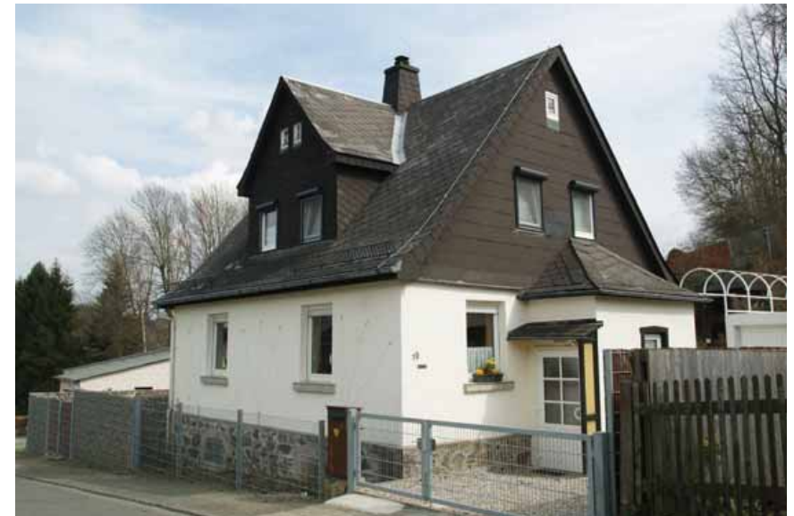
(I.) Wohnhaus von Nordwesten
