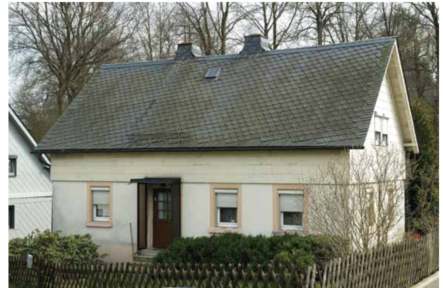
(I.) Wohnhaus von Nordwesten
