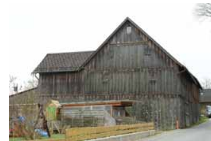
(II.) Scheune von Norden
