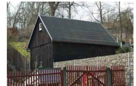
(II.) Schuppen von Nordosten
