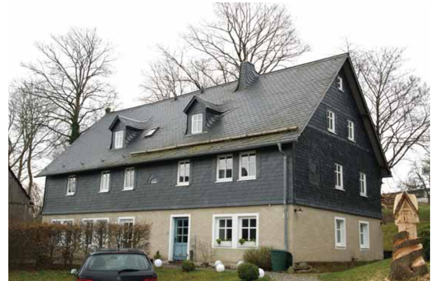
(I.) Wohnhaus von Nordwesten
