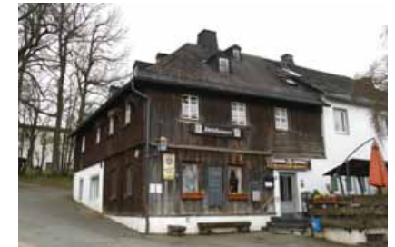
Dorfplatz 8, im Kern Blockbau CR1208
