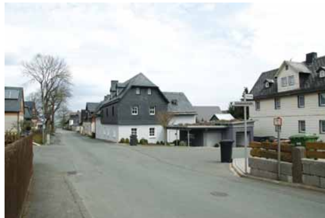
Abzweig Siemesweg von der Schleeknockstraße, von Süden
