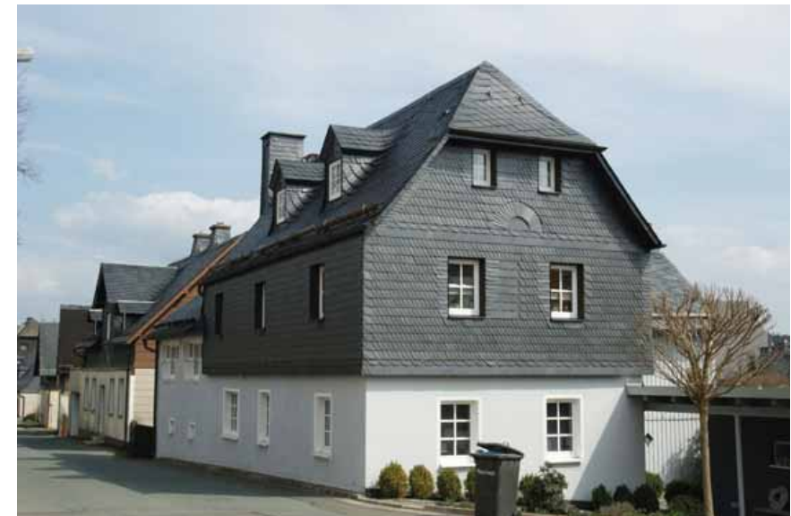
(I.) Wohnhaus von Nordwesten
