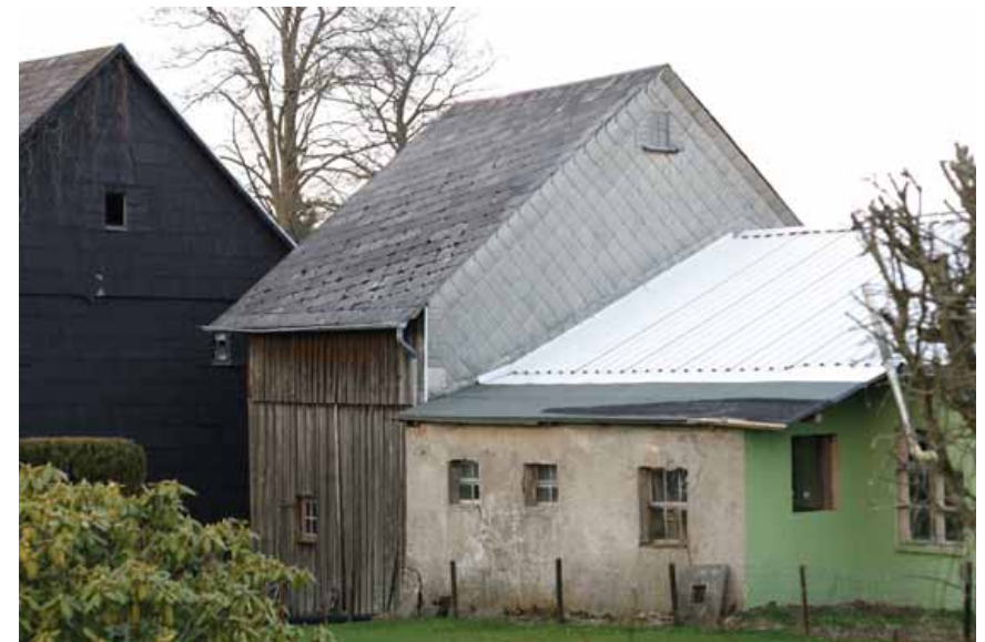
(I.) Scheune von Südwesten
