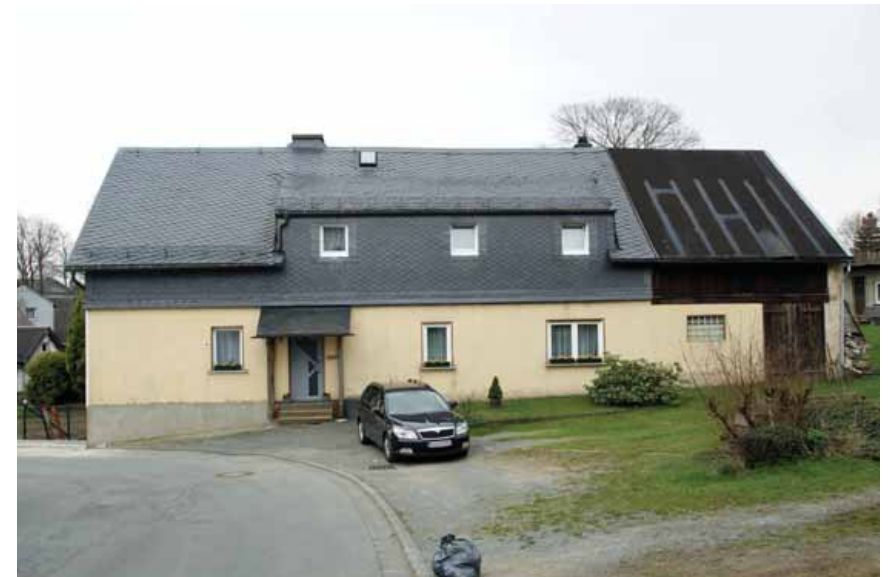
(I.) Wohnhaus von Nordwesten
